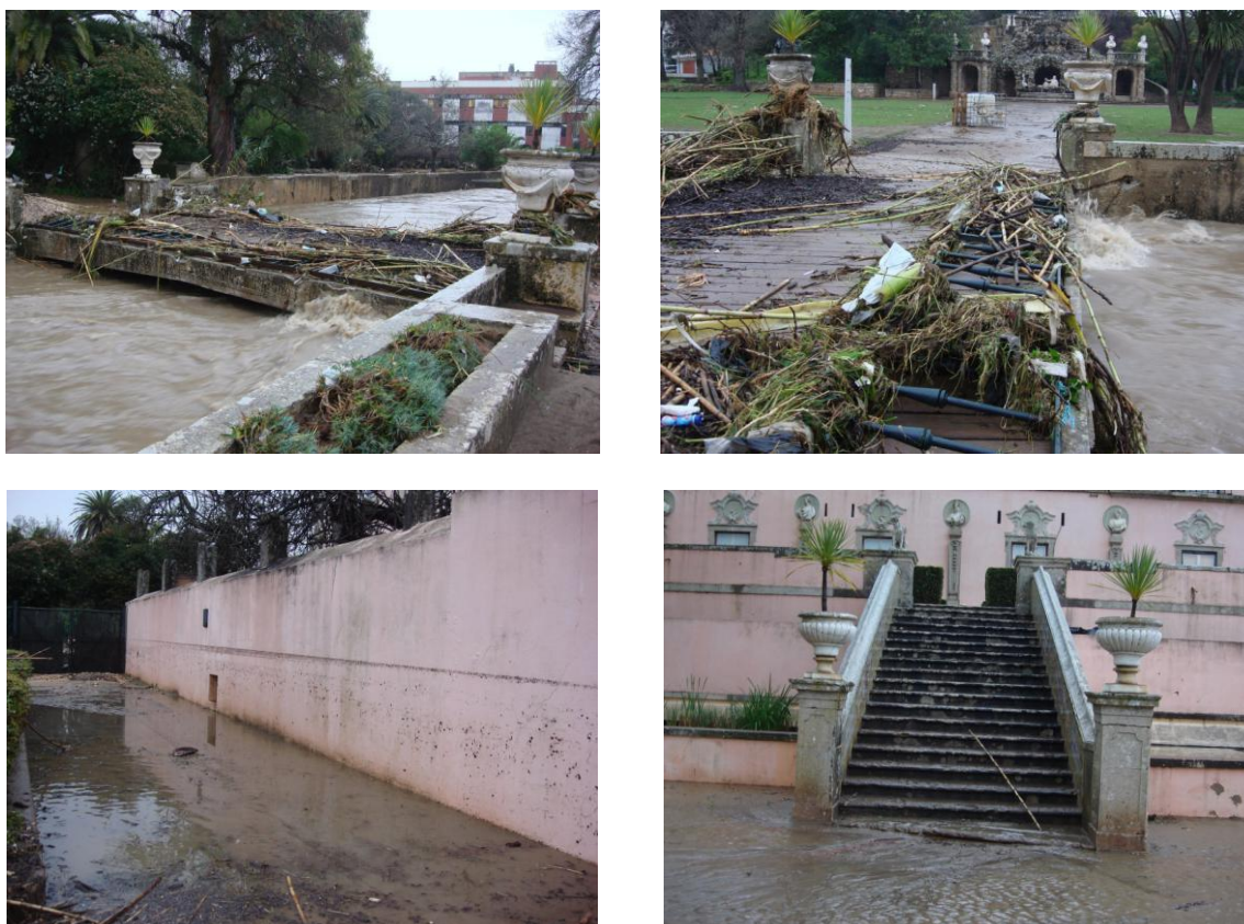
Figura 5.2 – Fotos de Fevereiro de 2008, da ribeira da Laje, na Quinta do Marquês de Pombal onde são visíveis as marcas de água
