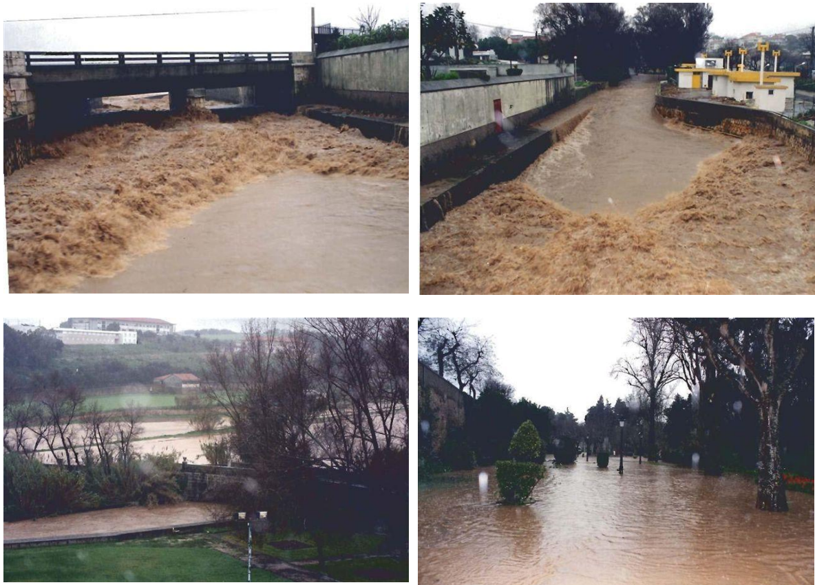
Figura 5.4 – Fotos das cheias de 1996, da ribeira da Laje, na Quinta do Marquês de Pombal e zona final da Ribeira da Laje
