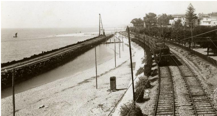
Figura 16 - Deslocamento lateral da linha férrea em Algés em 1939, ilustrando a construção sobre aterro. A via em utilização corresponde ao atual traçado da Avenida Marginal. Fonte: https://biclaranja.blogs.sapo.pt/2007/02/
