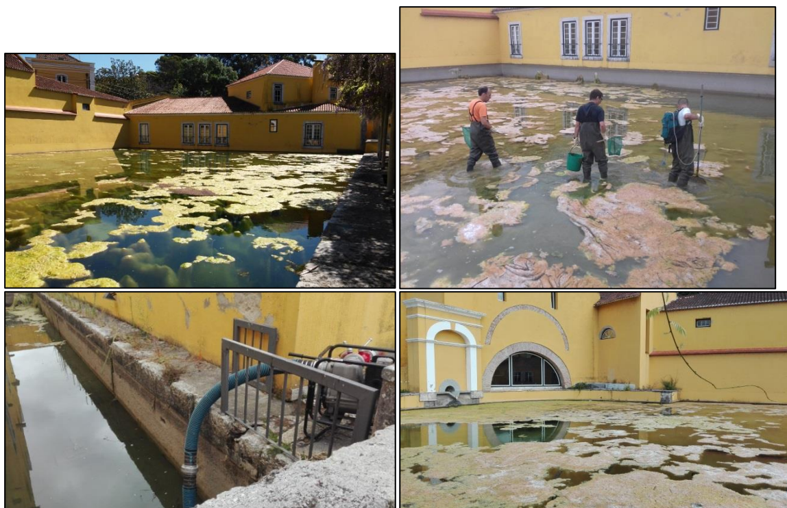
Figura 5. Caldeira dos Engenhos: antes e durante a limpeza do tanque
