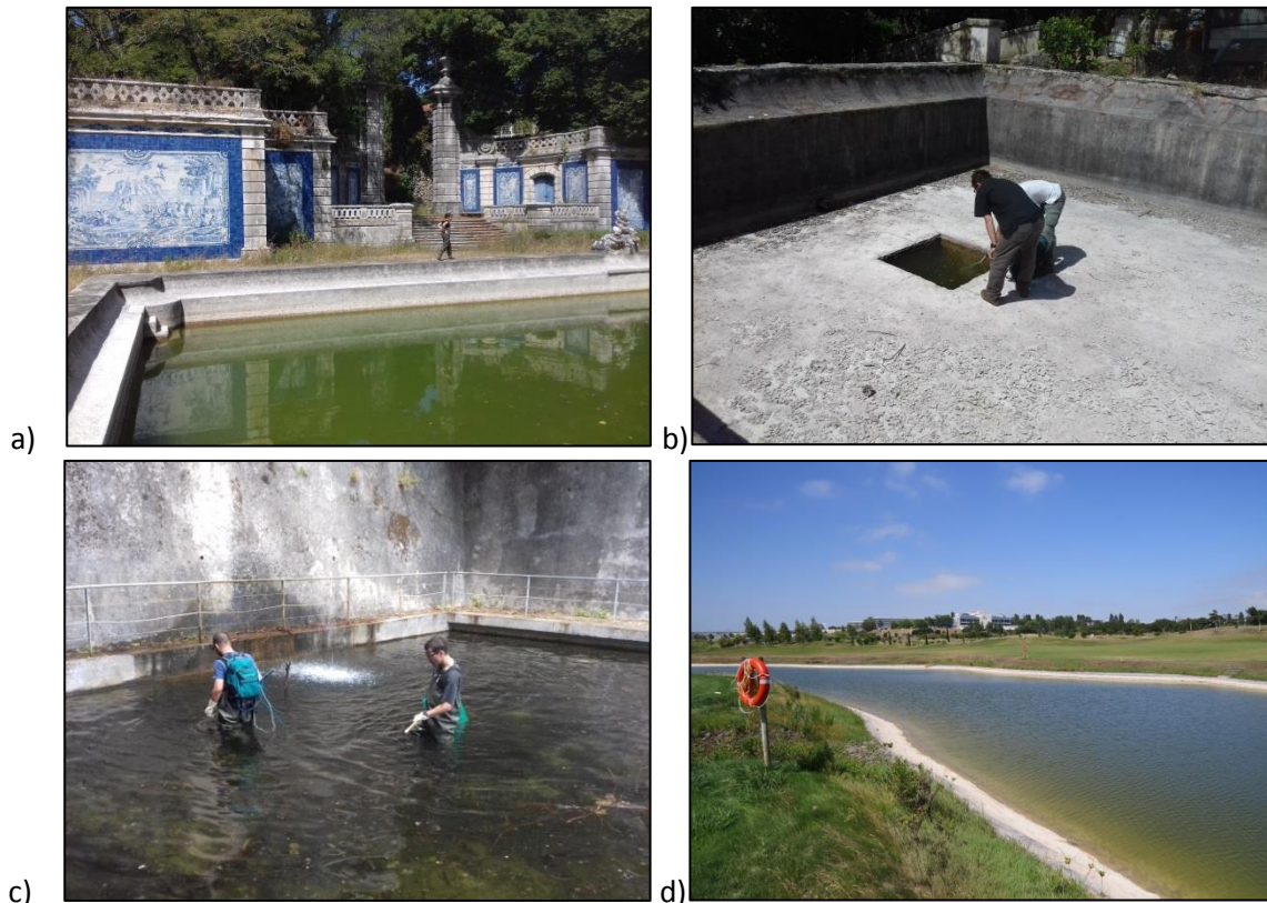
Figura 2. Massas de água artificiais: a) Tanque da Casa das Pescas, b) tanque da Cascata dos Poetas, c) tanque do Piquenique e d) lago do campo de golfe
