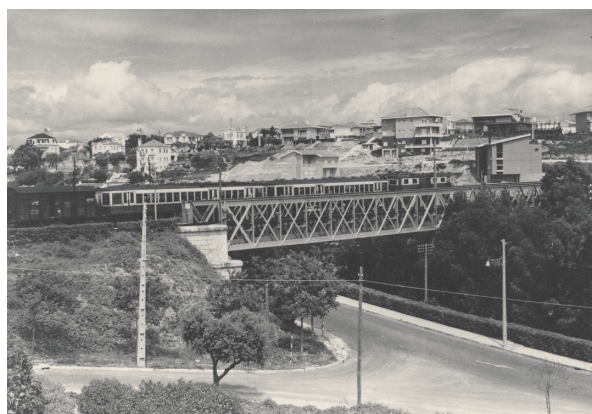
Ponte de caminho de ferro em Oeiras
