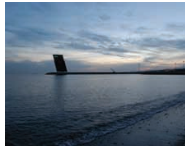
Torre de controlo marítimo
