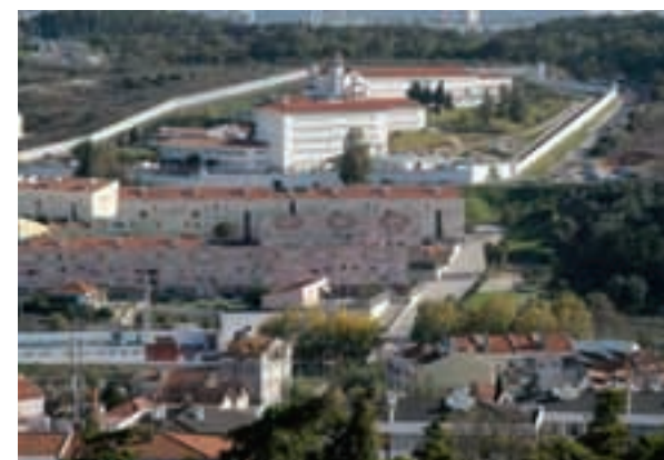
Hospital-prisão São João de Deus
