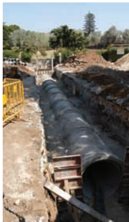
Obras de saneamento básico em Oeiras
