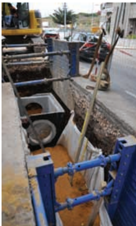
Obras de saneamento básico em Algés
