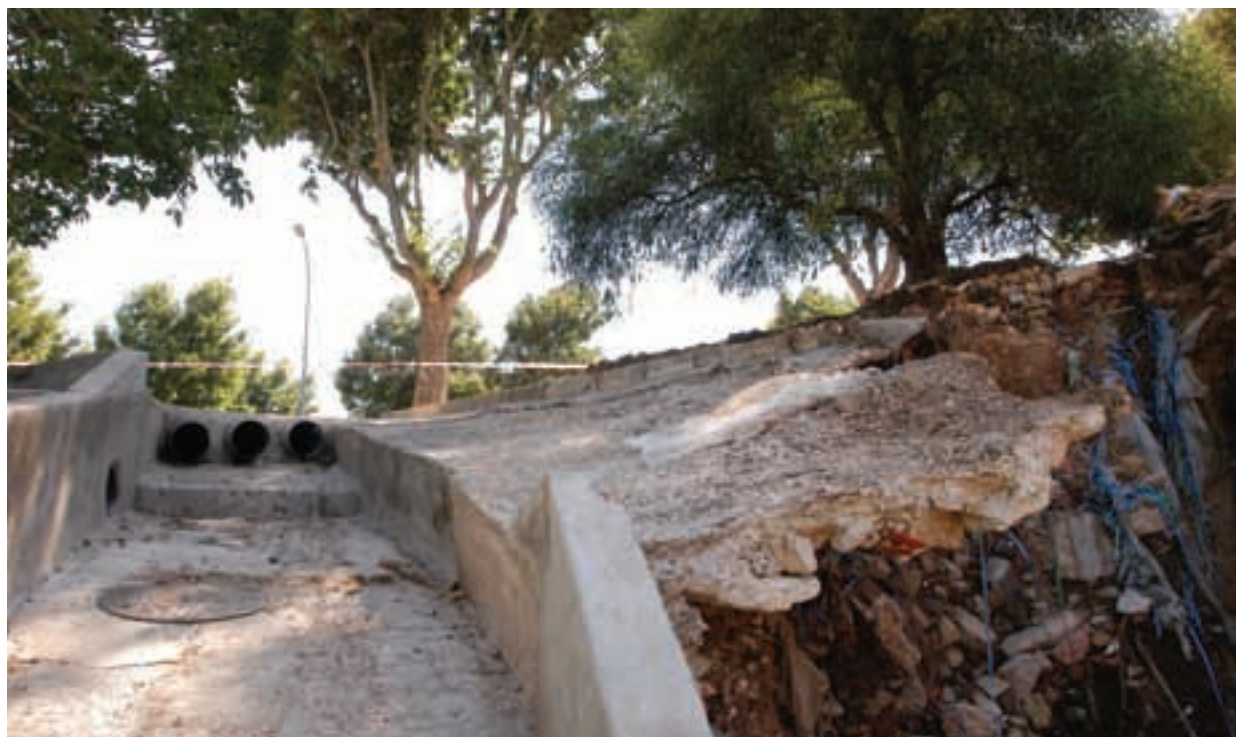
Obras de saneamento básico em Barcarena, Tercena
