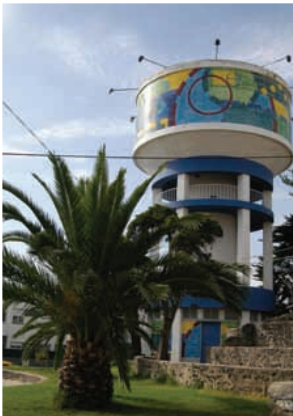
Reservatório de água de Linda-a-Velha
