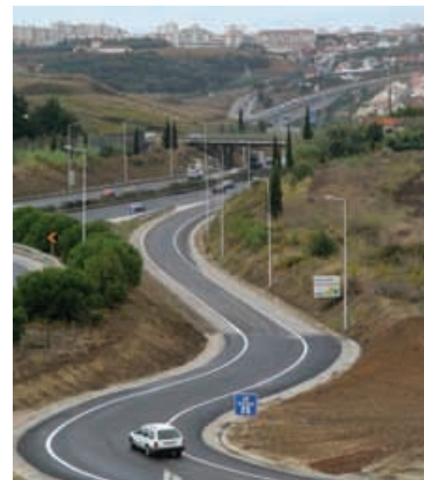
Acesso à A5
