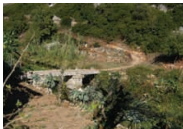
Ponte de Pedra da Lage
